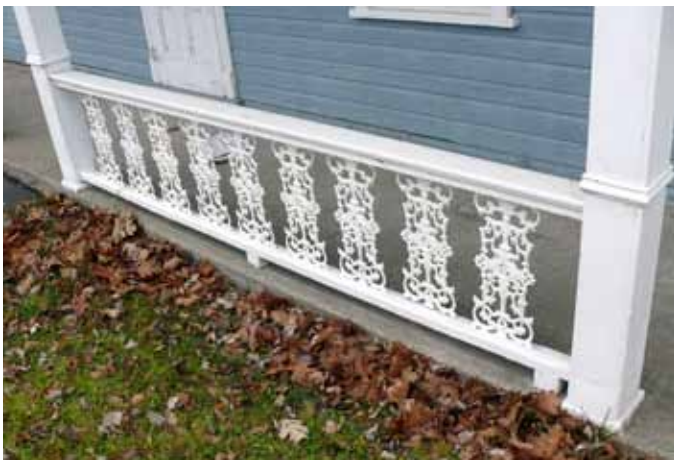
Balustrade en fonte sur une maison sise au 181, rue Saint-Jacques à Sainte-Thècle.
