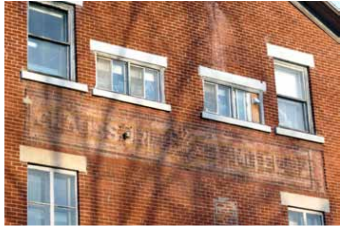
Brique de revêtement sur l'une des façades de l'ancien collège de garçons de Saint-Tite, sis au 501, rue Saint-Gabriel, qui est devenu l'usine de bottes Boulet.
