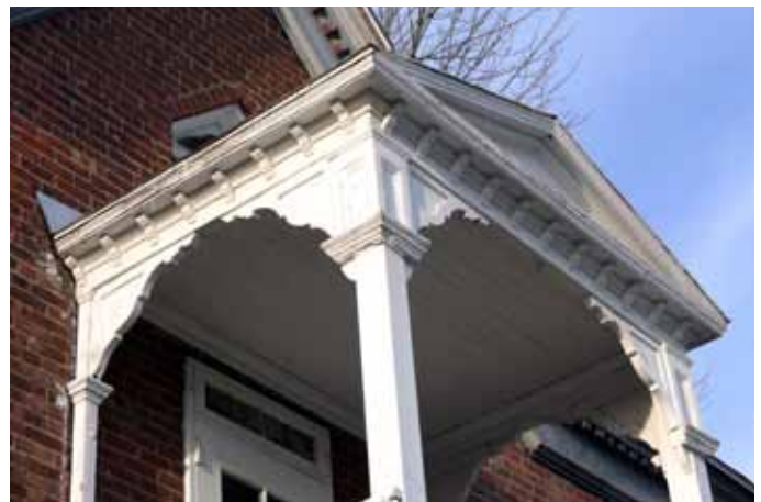
Bel auvent de balcon décoré de poteaux travaillés, d'un fronton mouluré et d'aisseliers sur une maison sise au 421, rue Saint-Paul à Saint-Tite.
