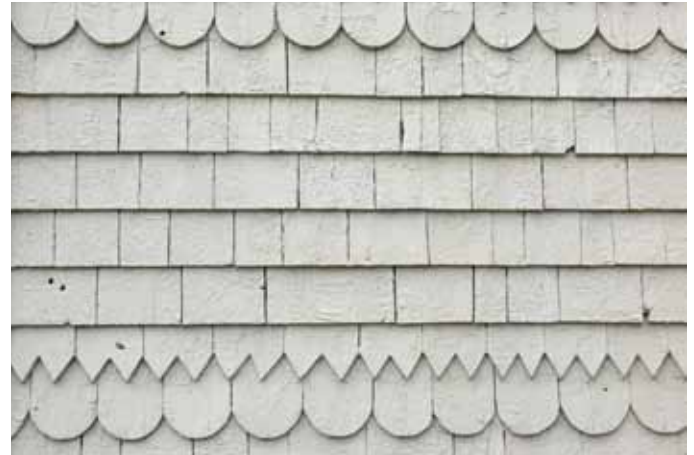
Revêtement de bardeaux découpés sur une maison sise au 220, rue Masson à Sainte-Thècle.
