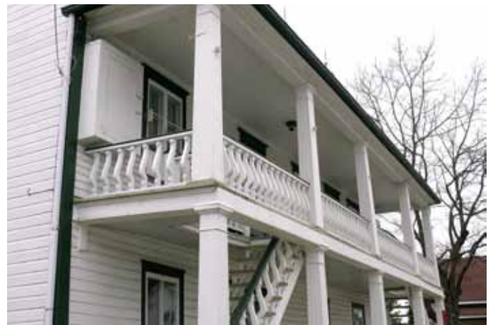
Garde-corps en bois observable au deuxième étage d'une maison sise au 323, rue Masson à Sainte-Thècle, qui a autrefois abrité une forge.
