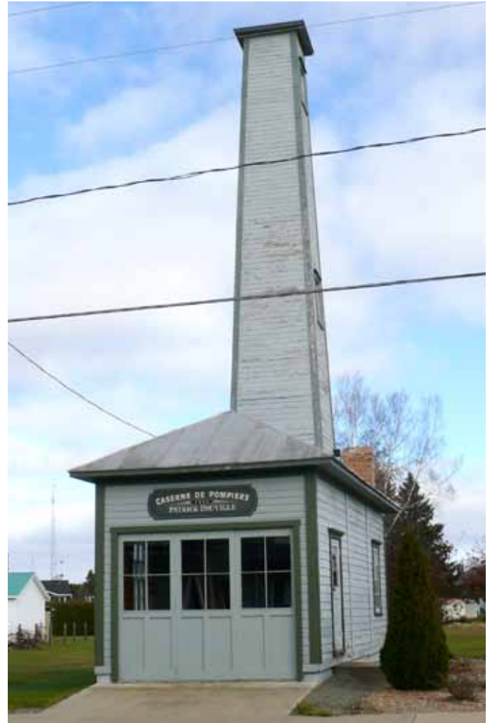
La caserne Patrick-Douville, sis au 391, rue Principale dans le village de Saint-Adelphe. Il s'agit d'un immeuble patrimonial cité.
