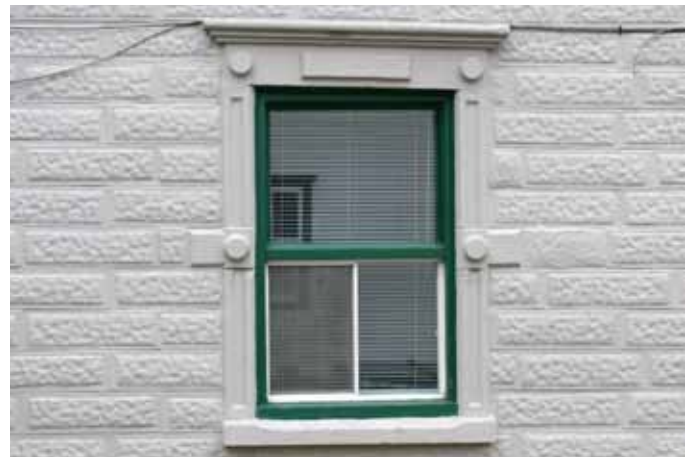
Chambranle en pierre sur une maison d'appartements sise au 307, rue Masson à Sainte-Thècle.
