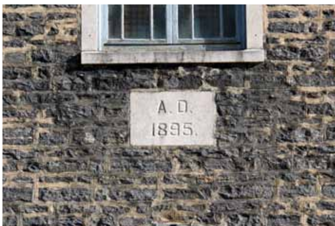
Pierre à moellons sur la base du clocher de l'église de Saint-Séverin.
