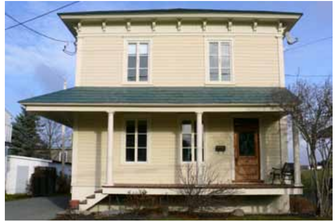
Revêtement de planches de bois horizontales sur une maison sise au 781, rue de la Montagne à Saint-Tite.
