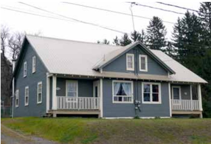
Maison jumelée sise au 670, 5 e Avenue à Grandes-Piles
