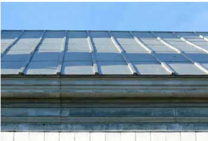
Tôle à baguettes sur l'église d'Hérouxville.
