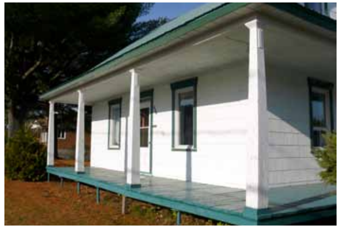
Poteaux d'une galerie d'une maison sise au 571, rang Saint-Pierre à Hérouxville.
