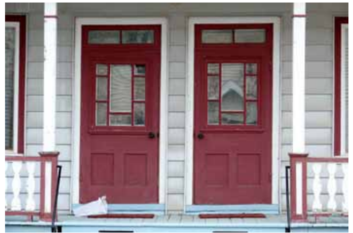
Portes en bois avec imposte sur une maison sise au 509, rue Principale à Notre-Dame-du-Montauban.
