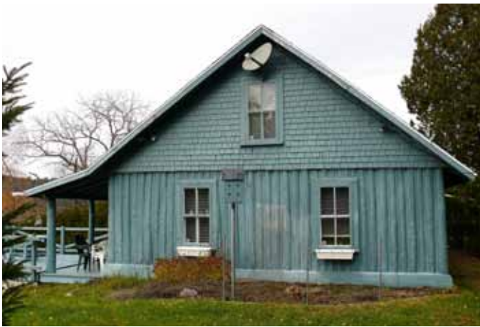
Revêtement de bardeaux de bois et de bois rond sur un chalet sis au 1421, rue Principale à Saint-Roch-de-Mékinac.
