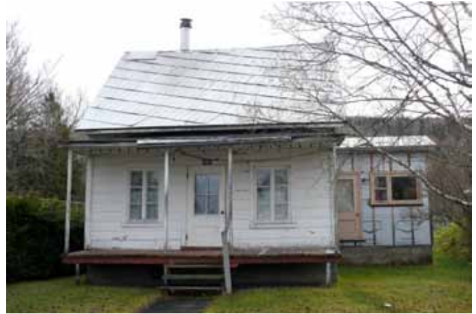
Tôle à la canadienne sur une maison sise au 445, rue du Couvent à Notre-Dame-du-Montauban.
