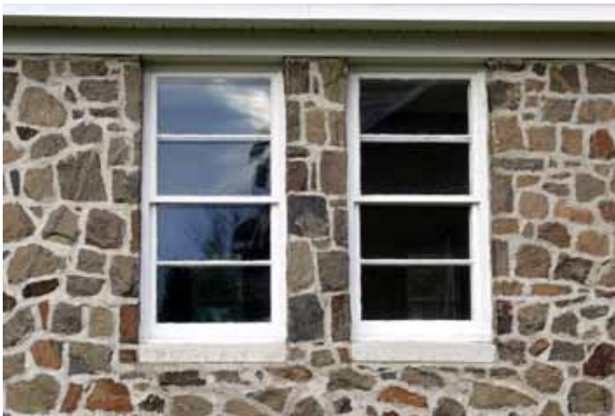
Fenêtres à guillotine avec de grands carreaux sur l'église de Saint-Roch-de-Mékinac.
