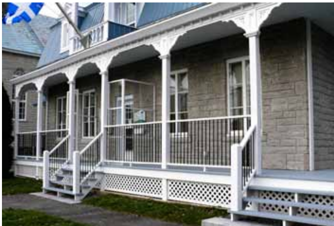
Succession d'aiseliers sur la galerie de l'ancien presbytère de Grandes-Piles, sis au 630, 4 e Avenue.
