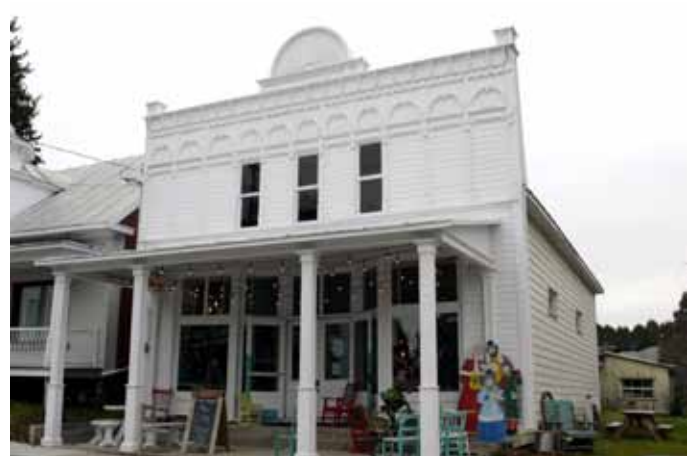
Superbe façade décorée de boiseries sur un ancien magasin général sis au 290, rue Masson à Sainte-Thècle.
