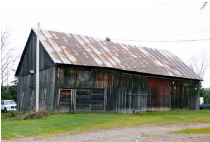
Revêtement de planches de bois verticales sur un bâtiment secondaire attenante à la maison sise au 180, chemin de la Rivière, dans le secteur de Saint-Joseph-de-Mékinac à Trois-Rives.
