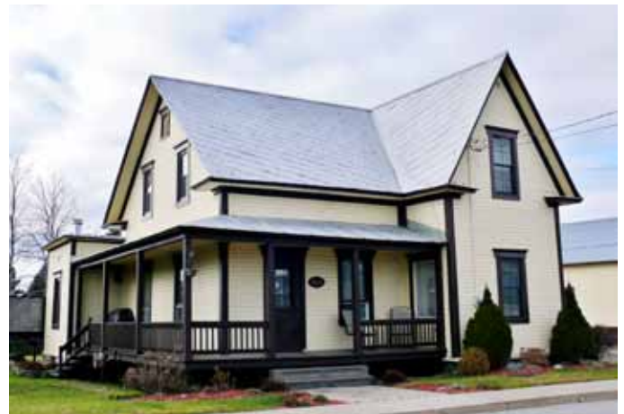
Revêtement de planches de bois horizontales sur une maison sise au 350, rue Principale à Saint-Adelphe.
