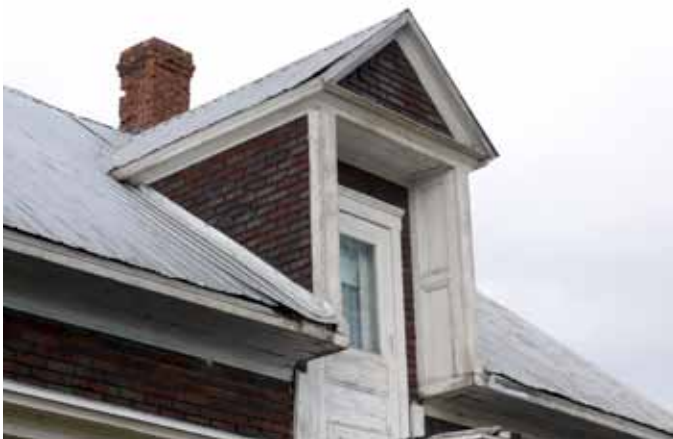
Lucarne pendante s'ouvrant sur le balcon d'une maison sise au 221, rang Saint-Joseph à Saint-Adelphe. Il s'agit ici d'un type particulier de lucarne propre à la région de la MRC de Mékinac.
