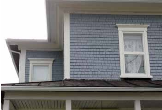
Bardeaux de bois peints en bleu pâle sur une maison sise au 1485, route 367, du secteur de Montauban-les-Mines à Notre-Dame-de-Montauban.
