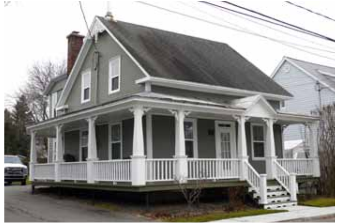
Belle galerie couverte avec poteaux de bois sur une maison sise au 210, rue Saint-Gabriel à Saint-Tite.
