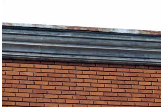
Corniche métallique moulurée sur une maison sise au 510, rue Notre-Dame à Saint-Tite.
