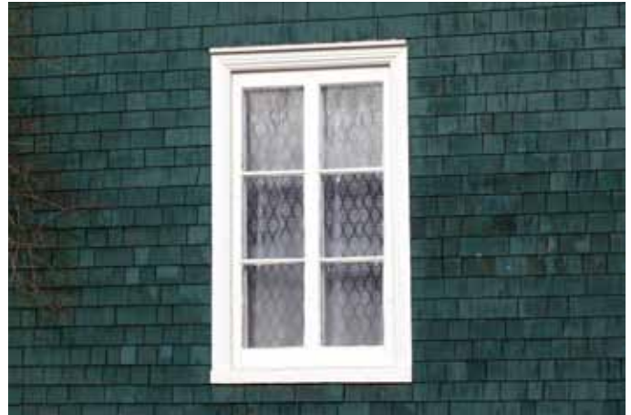
Fenêtre à battants avec de grands carreaux sur une maison sise au 721, rue Saint-Alphonse à Lac-aux-Sables.
