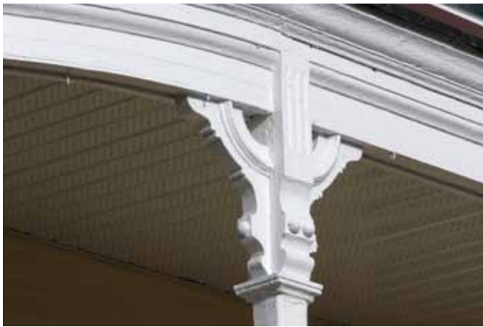
Aisseliers de la galerie du presbytère de Saint-Séverin, sis au 41, boulevard Saint-Louis.
