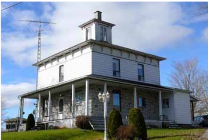
Maison de ferme avec la tourelle d'observation sise au 380, chemin des Moulins à Saint-Séverin. Il s'agit de la seule maison de ce style à faire partie de l'inventaire en raison de l'état d'authenticité de la tourelle.
