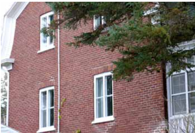
Brique de revêtement sur une maison sise au 790, 4 e Avenue à Grandes-Piles.
