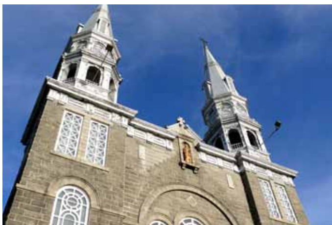
Revêtement de pierre à bossage sur l'église de Saint-Tite.
