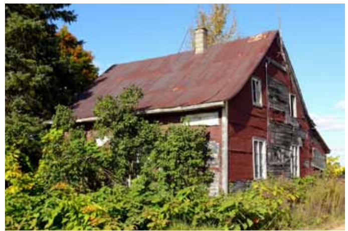
Maison à l'abandon près de la route 159 à Saint-Séverin.
