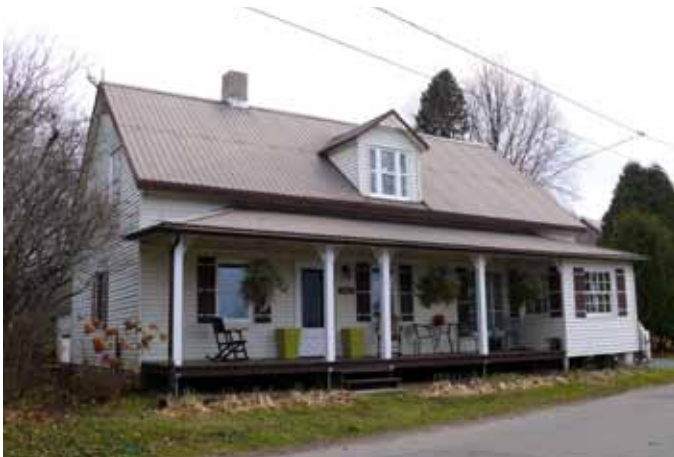
1132, rue Principale à Saint-Roch-de-Mékinac. Ce style architectural est assez rare dans les secteurs développés le long de la rivière Saint-Maurice. Il s'agit ici d'un exemple où le toit ne possède pas de versant incurvé.
