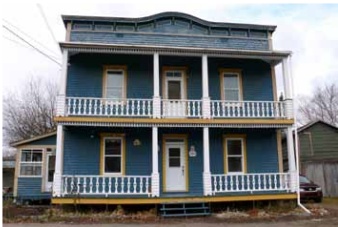
380, rue Principale à Notre-Dame-de-Montauban
