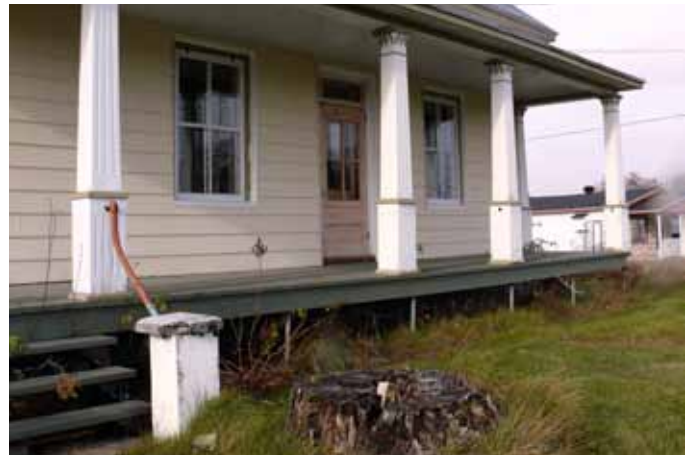
Poteaux d'une galerie d'une maison sise au 761, rue Saint-Jacques à Sainte-Thècle.
