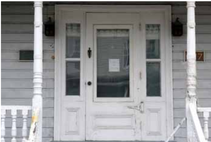
Porte en bois sur une maison sise au 477, rue Principale à Notre-Dame-de-Montauban.
