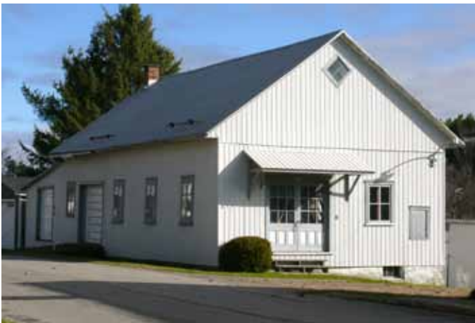
Boutique à bois attenante au 611, chemin des Moulins à Saint-Séverin.
