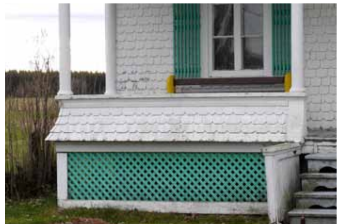
Garde-corps fermé à hauteur d'appui et paré de bardeaux de bois, sur une maison de ferme sise au 1772, route 159 à Saint-Séverin.
