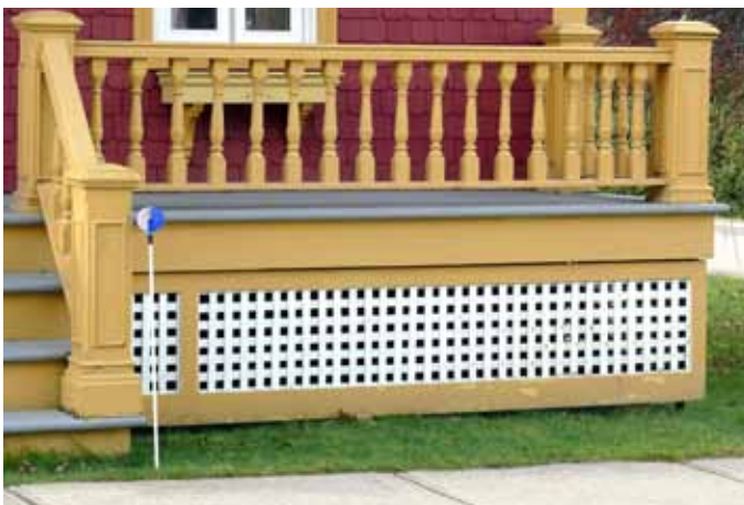
Balustrade en bois sur une maison sise au 130, boulevard Saint-Louis à Saint-Séverin.
