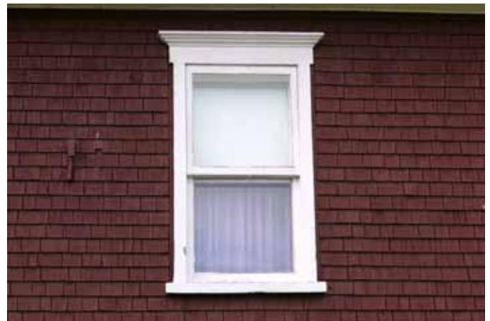
Chambranle mouluré sur une maison sise au 1526, route 367, dans le secteur de Montauban-les-Mines à Notre-Dame-du-Montauban.
