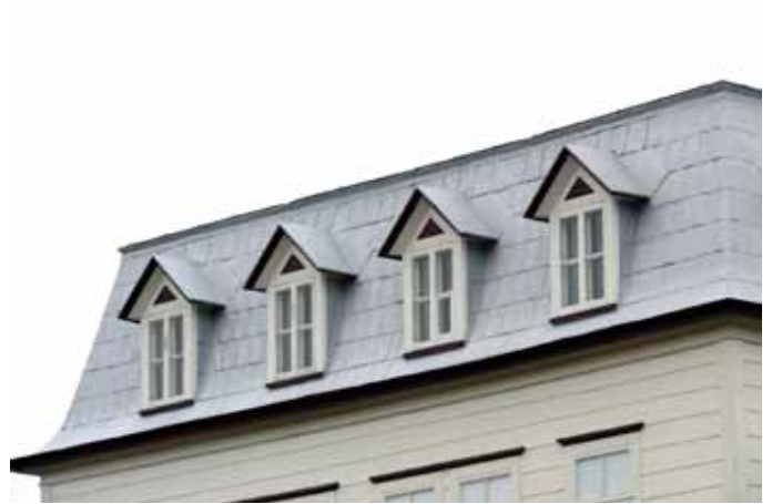
Tôle en plaque sur la toiture de l'ancien couvent de Sainte-Thècle sis au 283, rue Dupont.
