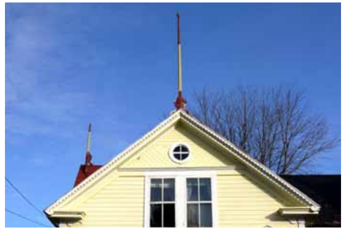
Mat de drapeau et denticules bordant le toit sur une maison sise au 211, rue Notre-Dame à Saint-Tite.
