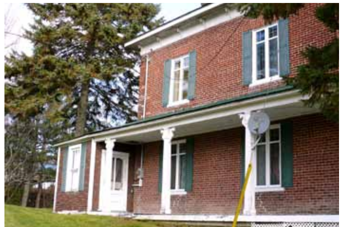
Brique structurale sur une maison sise au 200, route 159 à Saint-Séverin.
