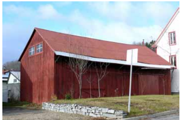
Bâtiment secondaire en bois peint en rouge attenant au 253, avenue des Chutes à Notre-Dame-du-Montauban.
