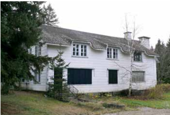
Manoir du domaine McCormick sis au 5071, route 155, dans le secteur de Grande-Anse à Trois-Rives.
