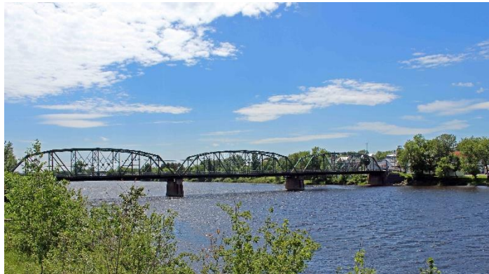
Figure 32. Ancien de pont de Saint-Stanislas (MRC des Chenaux, Qc)
